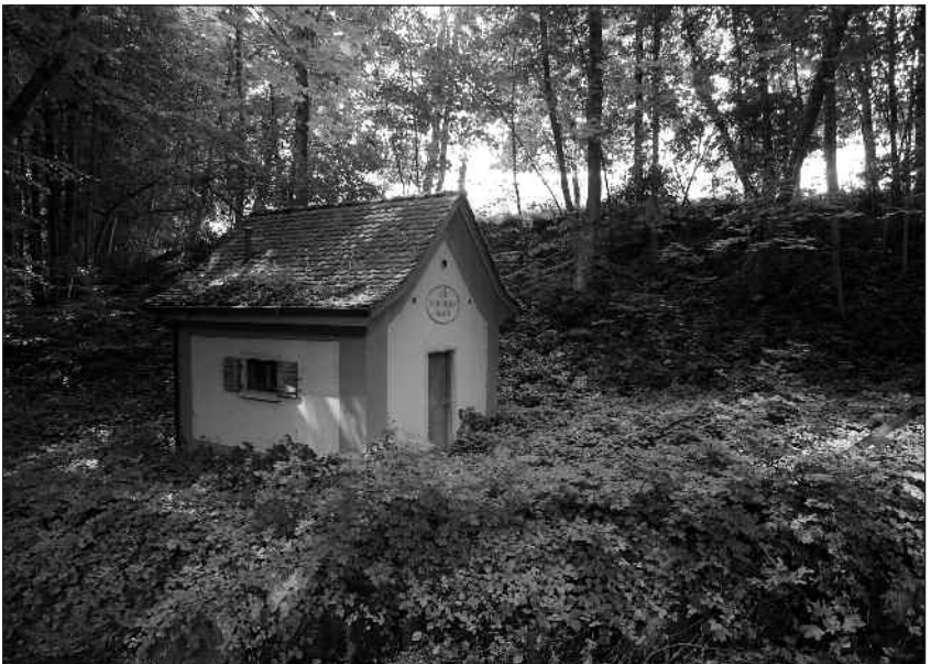
2008, Pumpwerk der Wasserversorgung Langnau
